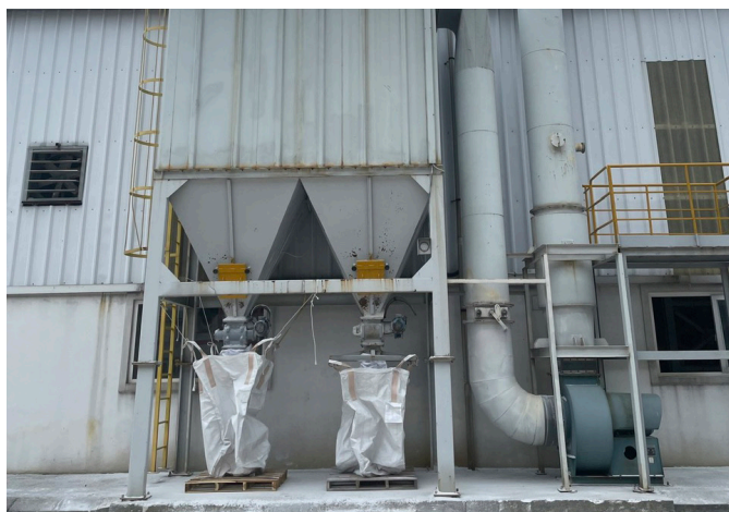
Hệ Thống Hút Bụi Cyclone Nhà Máy Đá Phenikaa
