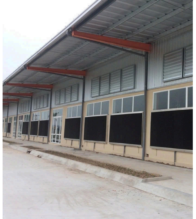
Hệ thống thông gió áp âm
