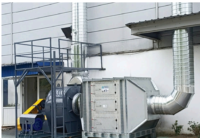
Hệ Thống Xử Lý Khói Hàn Phú Thuận Toàn
